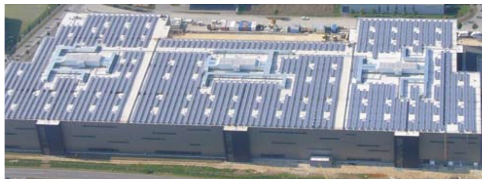
Installation 1 MW, installation sur toiture (Allemagne) Impianto 1MW, su tetto (Germania)
