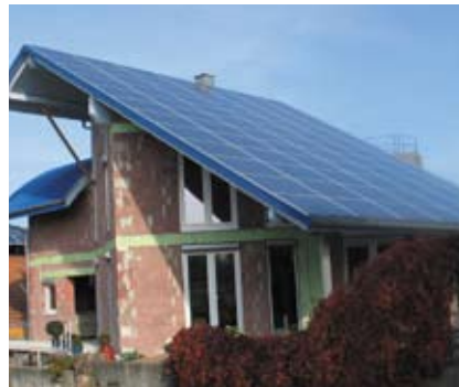
Installation 17 kW, installation sur toiture (Allemagne) Impianto 17kW, su tetto (Germania)
